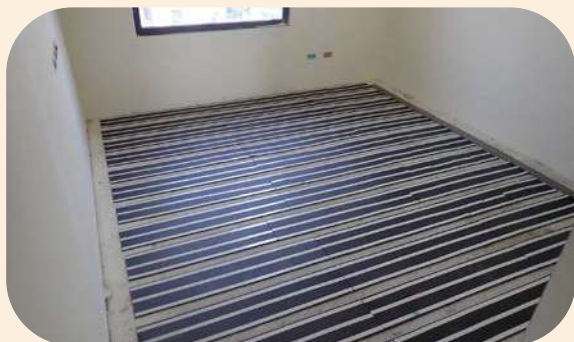
Step.2 鋪設斷熱 / 隔音層
