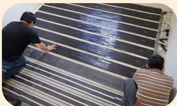
Step.3 鋪設電熱片
