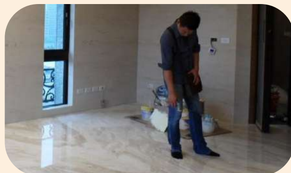
Step.7 地板鋪設完成後檢測及驗收
